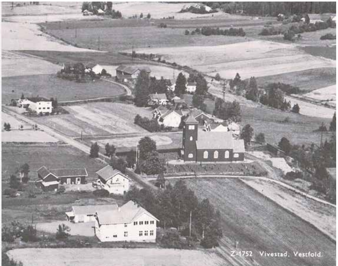
Postkort fra Vivestad sentrum. I forgrunnen skolen og butikken til Medhus. Rett bak kirken sees Skjønberg. Den store hvite bygningen bak kirken er ysterbygningen.
