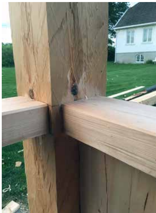
Fagmessig utført innfelling eller «tapping».
