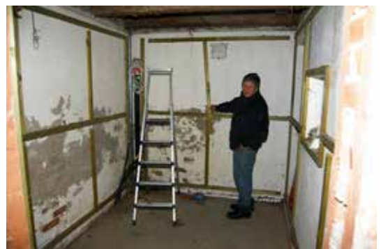
Et av toalettrommene med støpt gulv og rørlegg. Rørlegger og nestleder i stiftelsen Karl Anders Bråten viser hva som er gjort.
