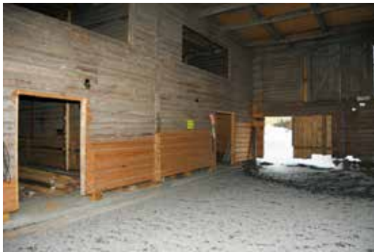
Utgraving og grusing i mellomlåven.
