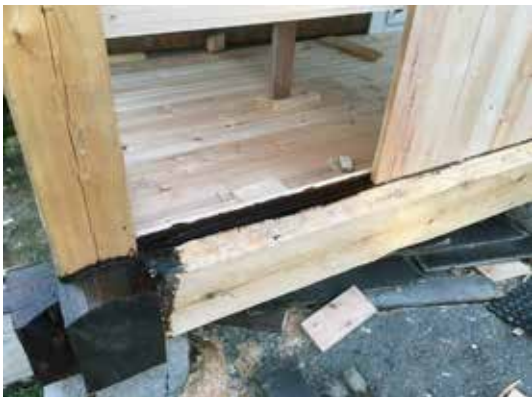
Lafteknutene innsmurt med tjære under montering.
