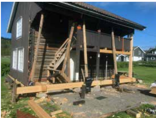
Fasaden «avkledd» og nye bunnstokker og bjelker under montering.
