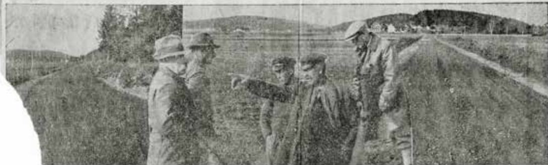
er fra veien Linnestad--Revetal som nu er åpnet for trafikk. Overingeniør Thor Larsen (t. h.) og en del grunneiere, som gjør sine bemerkninger. Fra venstre: Hans Bøe, Olaf Bøe og Linnestad sen. og jun.
