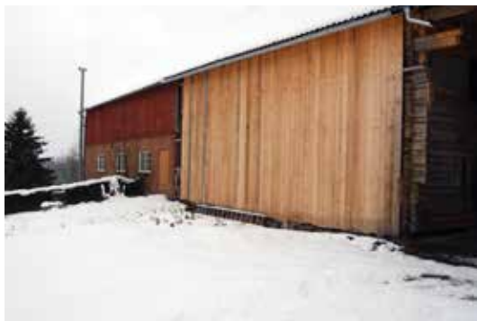
Ny kledning utenpå tømmeret.
