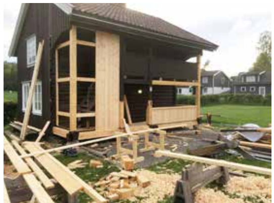
Kledningsbord er handhøvla og under montering.
